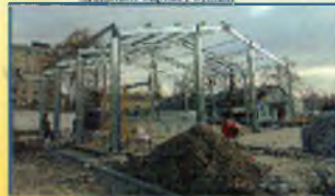
Монтаж каркасу будівлі
